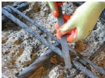
2. Una vez expuesta la armadura de acero que se va a reparar dentro del parche, se debe identificar la ubicación de los ánodos Sika® FerroGard®-500s Patch en el hormigón base adyacente al borde de la reparación (imagen superior izquierda).
