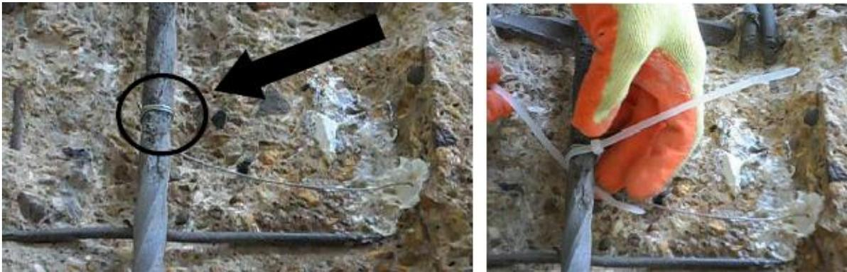
9. La resistencia eléctrica entre el punto de unión del ánodo Sika® FerroGard®-500s Patch y el acero debe confirmarse como  $<1$  ohmio utilizando un medidor adecuado. Si la resistencia es superior a 1 ohmio, se debe retirar el punto de unión del ánodo Sika® FerroGard®-500s Patch, limpiar el acero de refuerzo y volver a instalar el punto de unión del ánodo. Este proceso deberá continuar hasta que se logre una resistencia  $<1$  ohmio.
