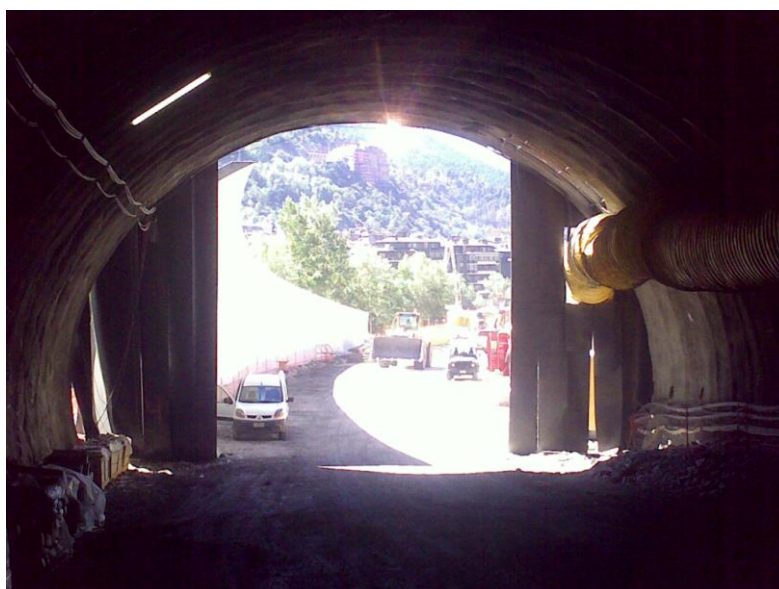
Foto1.- Detalles del emboquille sur del Túnel de Tapia
