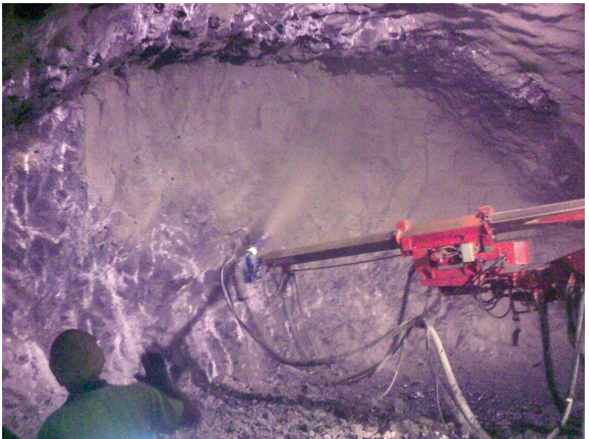
Foto2.- Proyección de hormigón en el frente de avance del Túnel de Tapia
