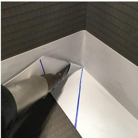
Soldar el detalle interior de la esquina con una pistola de soldadura de aire caliente.
