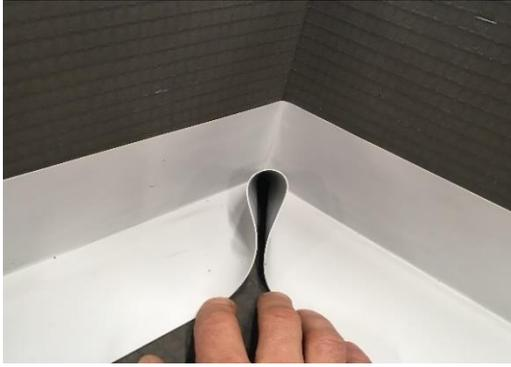
Coloque la banda centrada en el borde. Doble la cinta que sobresale en la esquina centrándola para que la cinta encaje correctamente.
