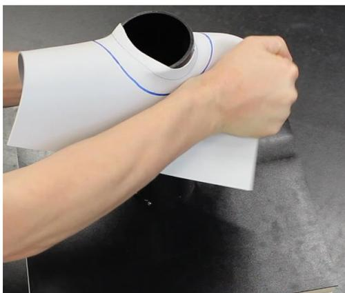
Pase la pieza de cinta precalentada por encima de la tubería.
