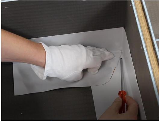
Compruebe cuidadosamente las uniones soldadas con un destornillador a ambos lados (si es accesible).
