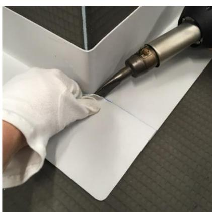
Fije la pieza de cinta adicional en el extremo de la esquina en su posición mediante puntos de soldadura.
