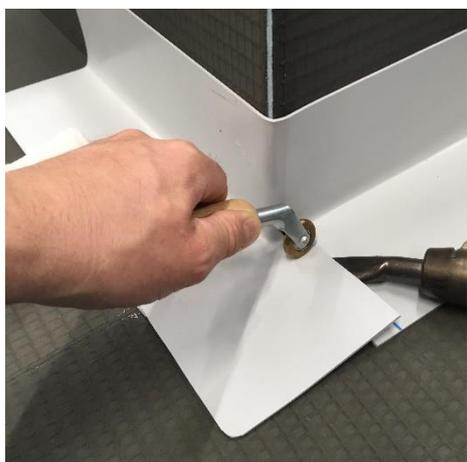
Suelde firmemente la pieza de cinta adicional a la siguiente cinta.
