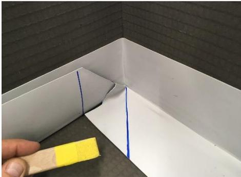
Corte el pliegue pero mantenga el pliegue en la esquina un mínimo de 50 mm (como se muestra en la imagen).
