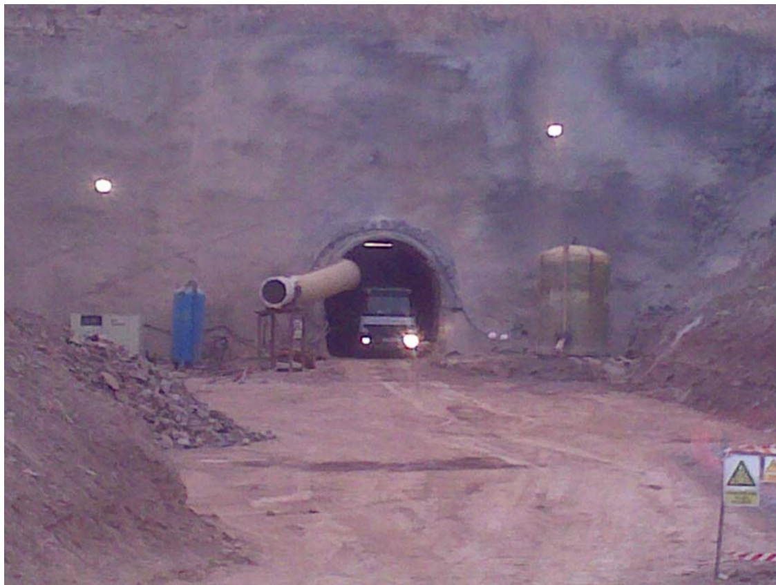
Detalle del emboquille del Túnel de La Figuerosa
