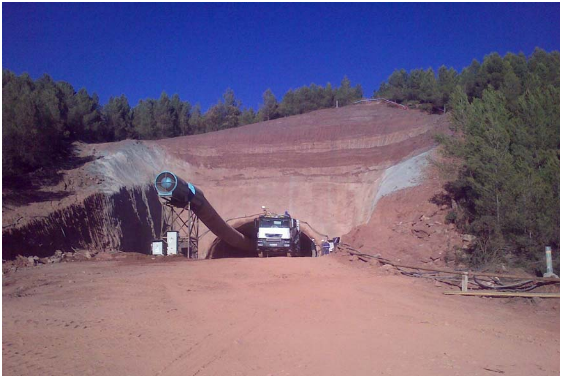
Detalle del emboquille del Túnel Montconil
