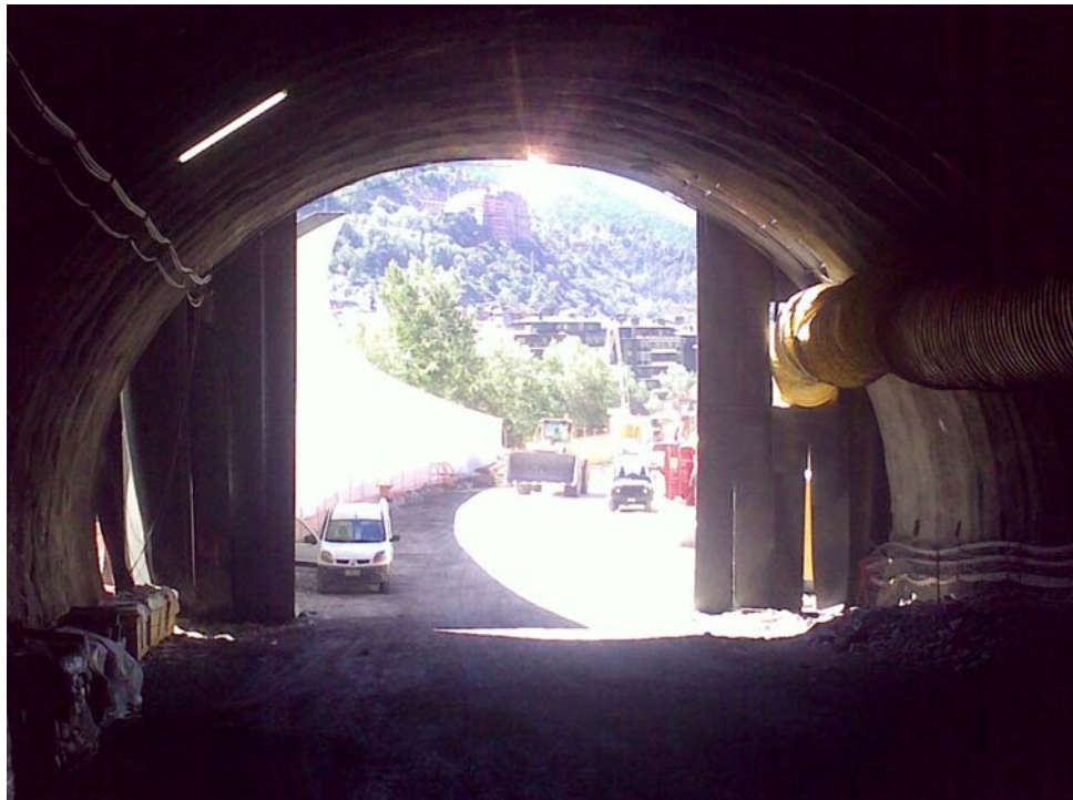
Detalles del emboquille y del interior del Túnel de Sant Julia
