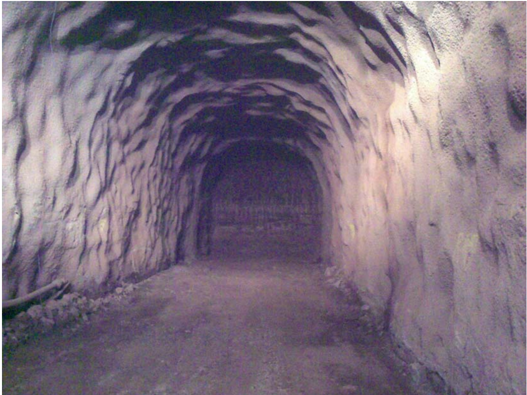
Detalle del interior del Túnel de La Figuerosa
