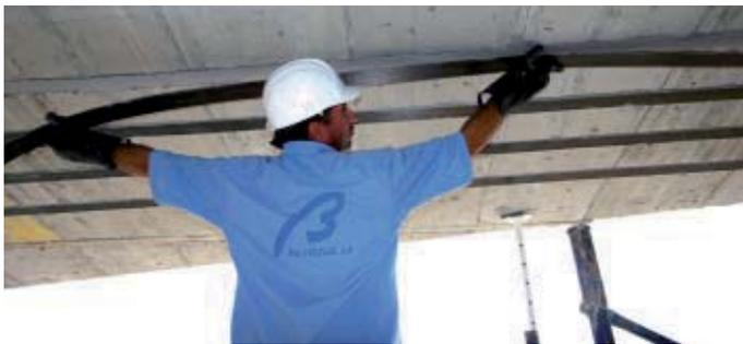
El corte del laminado en las longitudes deseadas se realiza en la propia obra y, una vez limpias las superficies, se procede a la aplicación sobre el soporte de una película de la resina epoxi.
