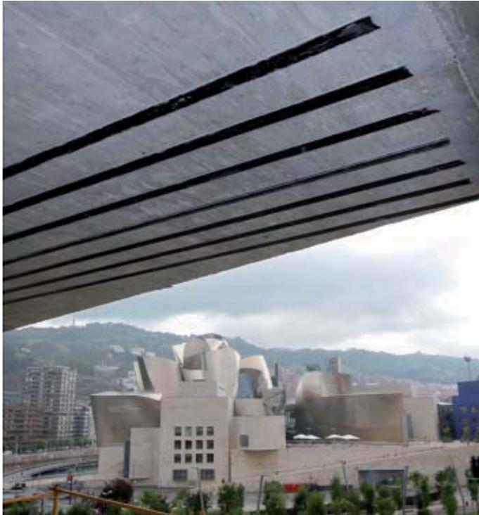
Betazul hubo de ejecutar un refuerzo de estructuras en la Biblioteca de la Universidad de Deusto, en Bilbao, mediante la aplicación del Sistema Sika Carbodur de polímeros reforzados con fibras de carbono (CFRP).
