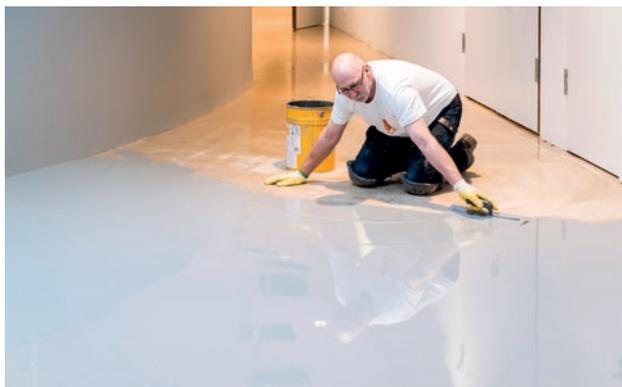
**PASO 3.** Los materiales autonivelantes se aplican en una o varias capas para crear una capa continua sin juntas. Los aplicadores especialistas vierten y distribuyen el material líquido mediante el uso de rastras o llanas, y posteriormente, le pasan un rodillo de púas para garantizar una superficie perfectamente lisa.
