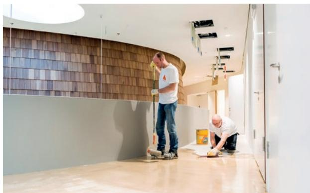
**PASO 2.** Se aplica una capa de imprimación líquida para garantizar un buen anclaje con el pavimento, normalmente se aplica con llana o rodillo de pelo corto. El método más adecuado puede seleccionarse en función de la calidad del soporte.
