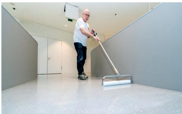
**PASO 5.** El toque final es la aplicación de una capa de sellado transparente o coloreada. Normalmente, esta capa se aplica con un rodillo o por pulverización. La capa de sellado garantiza el diseño final deseado, y añade resistencia al deslizamiento y al desgaste a todo el sistema.
