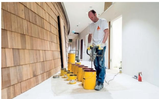
**PASO 1.** Después de la inspección y la preparación del soporte mediante la limpieza (y en caso de ser necesario lijado, granallado, fresado y/o nivelación), vamos a empezar a mezclar nuestros materiales líquidos.
