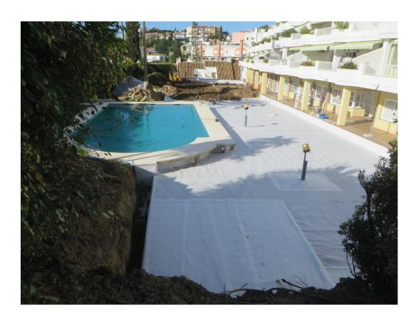
Se trata de una superficie ajardinada de 700 m², ubicada junto a bloques de apartamentos y piscina y sobre un parking subterráneo. Bajo este jardín, existe un forjado de hormigón con una impermeabilización inicial bituminosa de tela asfáltica, deteriorada y degradada, por lo que se suceden continuamente filtraciones de aguas al interior del parking, provocando a su vez, daños en la estructura del hormigón, a vehículos y pavimentos.
