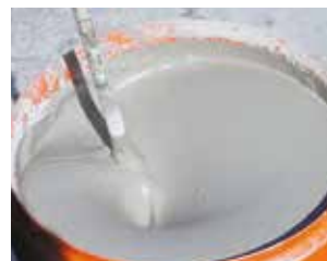
Mezclado de Sikafloor® Marine-100, -120 o -190
