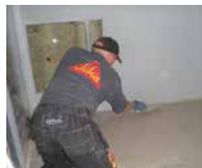
Aplicación de Sikafloor® Marine-100 o -120
