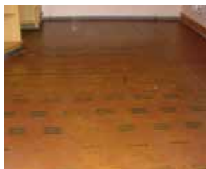
Aplicación de imprimación sobre la cubierta de acero con Sikafloor® Marine Primer C
