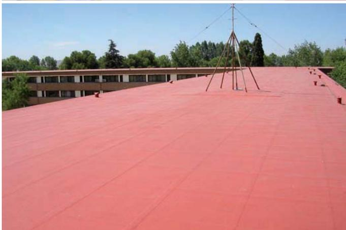
Opteimsa lleva a cabo la impermeabilización de una cubierta de 2.225 m<sup>2</sup> con acabado asfáltico en un edificio situado en Torrejón de Ardoz mediante el sistema Sikafill®, revestimiento elástico de consistencia cremosa, a base de copolímeros estirenoacrílicos en emulsión acuosa, que una vez seco forma una película flexible, impermeable y duradera.
