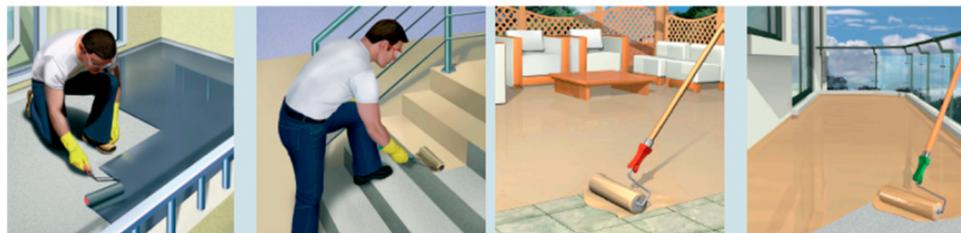
ES UN REVESTIMIENTO DE ALTA ELASTICIDAD, DE POLIURETANO MONOCOMPONENTE, CON DISOLVENTES, RESISTENTE A LOS RAYOS UV, COLOREADO Y CURA CON LA HUMEDAD AMBIENTAL.
