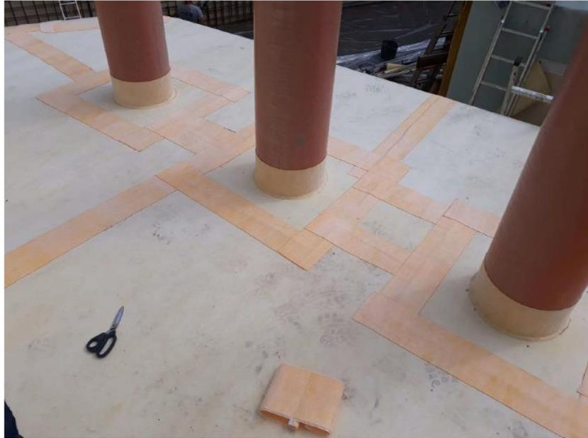
8. Inspección final de la instalación. Comprobación de juntas de solape, conexiones, etc.
