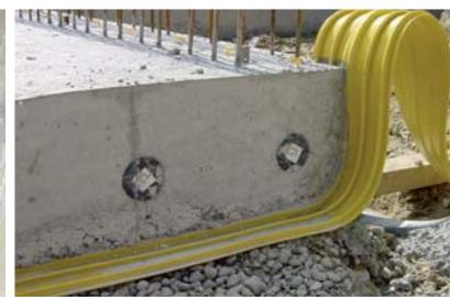
Impermeabilización integral de juntas
