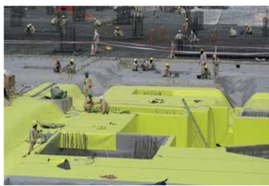
Membranas para impermeabilización de cimentaciones
