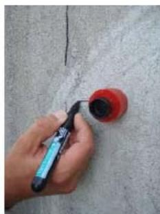
Marcar con el rotulador indeleble la posición de la armadura en la dirección vertical y horizontal sobre la superficie de hormigón.
