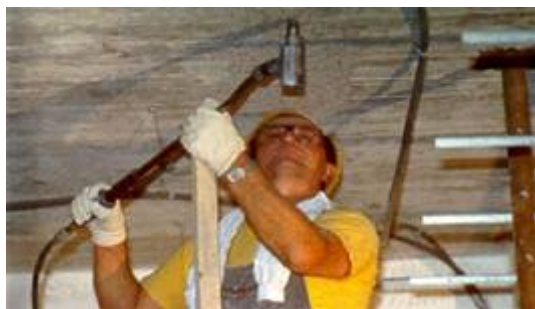
Fig. 4.1. Preparación soporte: Abujardado mecánico
