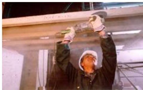
Fig. 4.2. Preparación soporte: limpieza con radial
