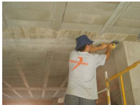
Fig. 4.4. Preparación soporte: lijadora con disco de diamante
