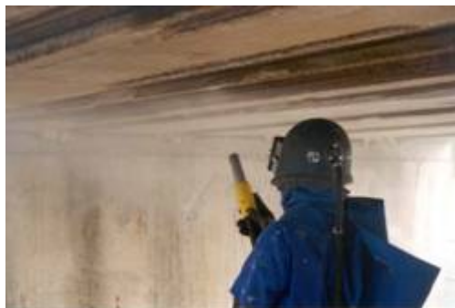
Fig. 4.3. Preparación soporte: chorro de arena
