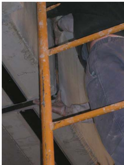
Fig. 7.10. Pegado del angular sobre el soporte
