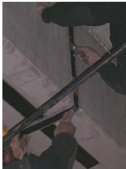
Fig. 7.11. Presión con el rodillo de goma sobre el angular
