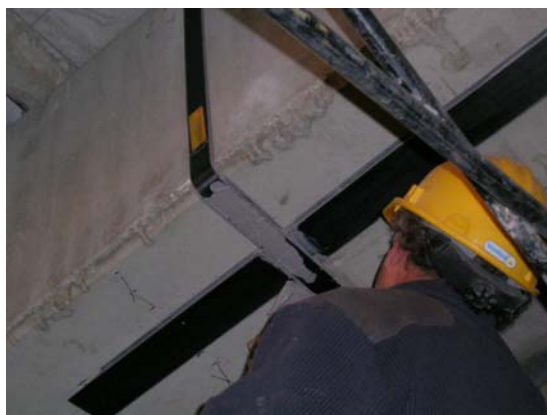
Fig. 7.16. Aplicación de la resina en el brazo inferior del angular
