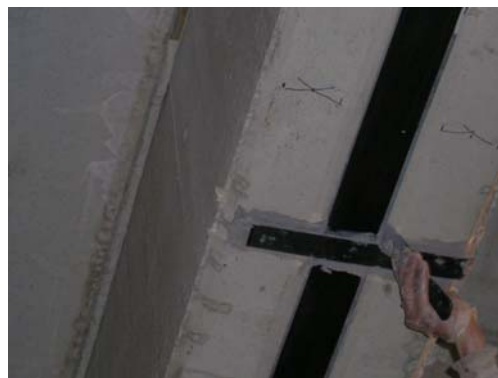
Fig. 7.13. Retirar el sobrante de resina
