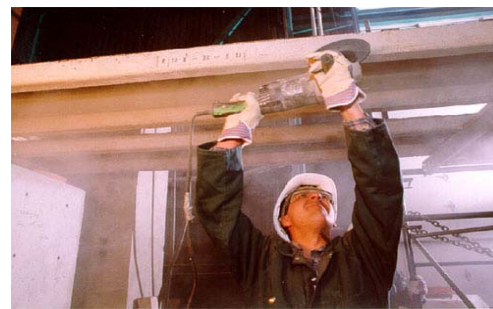
Fig. 5.3. Preparación soporte: limpieza con radial
