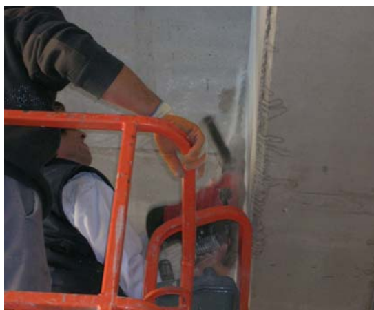
Fig. 5.9. Ejecución del agujero para el anclaje del angular
