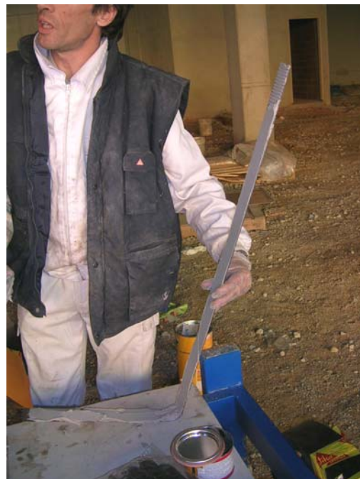
Fig. 7.7. Aplicación de la resina sobre el angular
