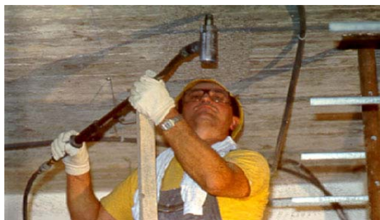
Fig. 5.2. Preparación soporte: Abujardado mecánico
