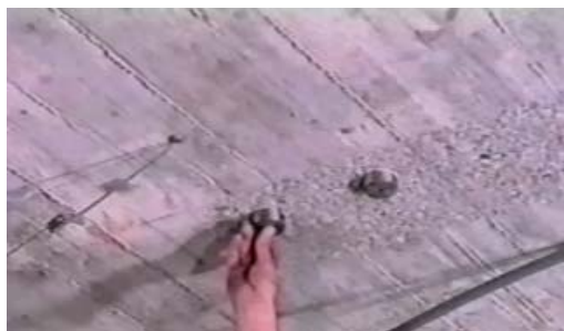
Fig. 5.14. Pegado de las sufrideras sobre el soporte
