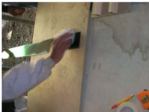
Fig. 7.3. Limpieza del laminado
