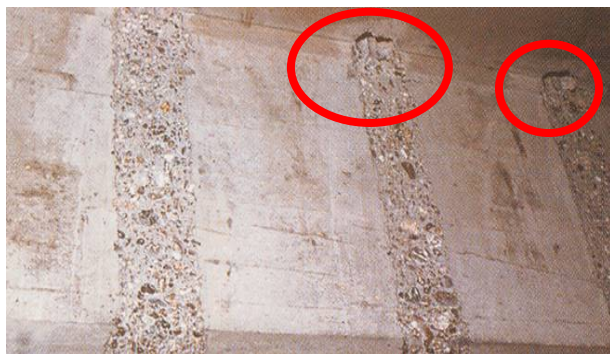
Fig. 5.7. Detalles de los agujeros para los anclajes de los angulares
