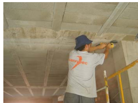
Fig. 5.5. Preparación soporte: lijadora con disco de diamante
