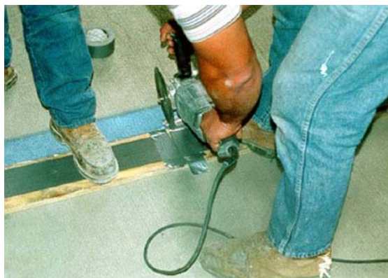
Fig. 3.1. Corte con radial
