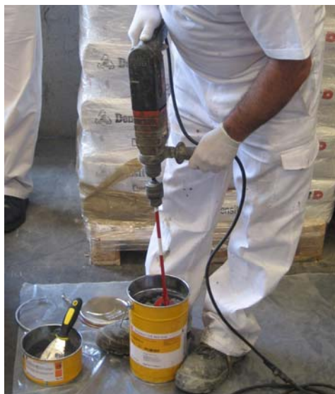
Fig. 6.3. Se mezclan los dos componentes con batidora de bajas revoluciones
