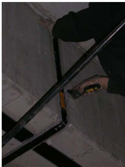
Fig. 7.12. Retirar el sobrante de resina
