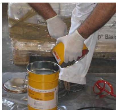
Fig. 6.2. Se vierte el componente B en el recipiente del componente A
