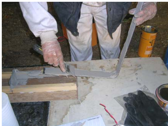
Fig. 7.7. Aplicación de la resina sobre el angular
