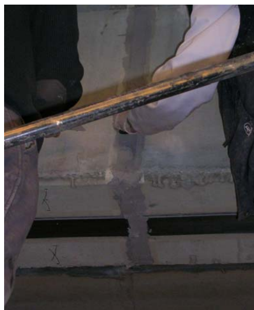
Fig. 7.6. Aplicación de la resina en el soporte angular
