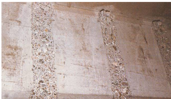
Fig. 5.6. Detalle de las zonas ya preparadas para los angulares
