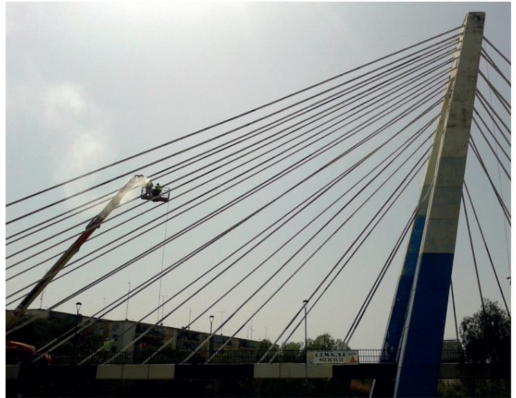
con agua a presión a más de 240 bares, consiguiendo la extracción de la suciedad del soporte y la eliminación de toda la pintura mal adherida. Con esta limpieza quedan claramente visibles todos los puntos con necesidad de restauración.
