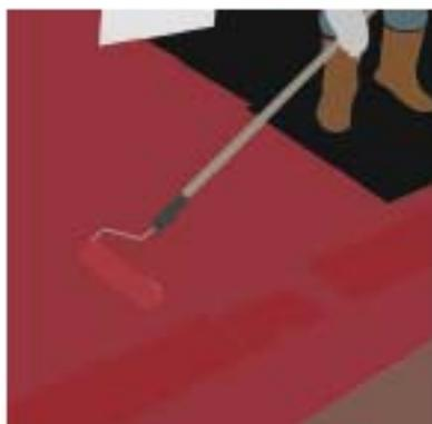
Aplique una capa inicial de Sikalastic®-601 BC ó Sikalastic®-602 BR sobre el soporte preparado y resistente de la cubierta usando el consumo adecuado.
