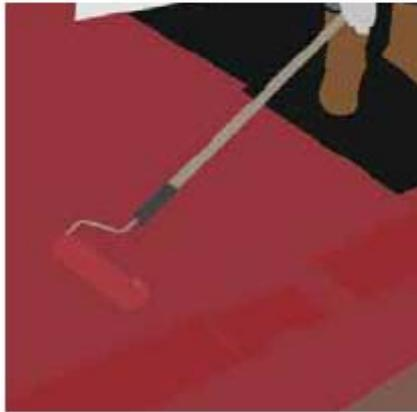
Aplice una capa inicial de Sikalastic®-601 BC sobre el soporte preparado y resistente de la cubierta aplicando el consumo adecuado.
