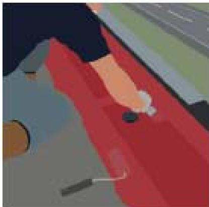
En todas las zonas de detalles se debe aplicar primero el Sikalastic®-602 BR con la malla de refuerzo Sika® Reemat Premium embebida en él. Se debe dejar que curen las zonas de detalles antes de aplicar el Sikalastic®-602 BR sobre toda la superficie de la cubierta.
