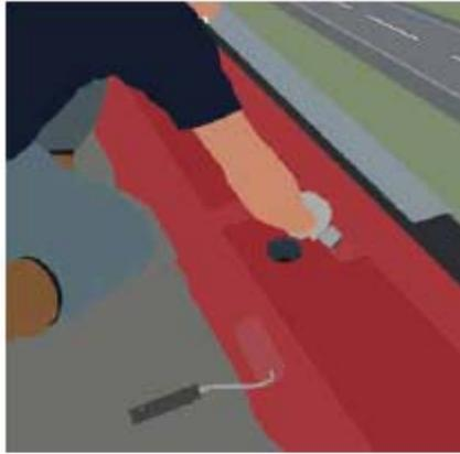
En las áreas de detalles, se deberá aplicar primero el Sikalastic® -601 BC con la malla Sika® Reemat embebida. Se deben secar estas áreas de detalles antes de la aplicación del Sikalastic®-601 BC sobre toda la superficie de la cubierta.
