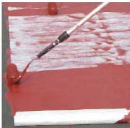
En fresco embeba la malla Sika® Reemat y pase un rodillo sobre la malla hasta que quede completamente embebida y saturada. Solape 50 mm de las mallas Sika® Reemat adyacentes asegurándose de que queda bien embebida. En este punto, compruebe que no quedan burbujas en el revestimiento y/o que no queda malla expuesta y si fuera necesario aplique más material. Deje secar antes de aplicar el Sikalastic®-621 TC.
