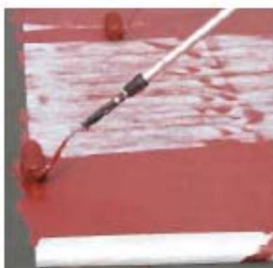
Mientras esté aún fresco el producto, coloque la malla Sika® Reemat pasando el rodillo hasta que quede completamente embebida y saturada. Solape 50 mm de las mallas contiguas asegurando que se ha colocado suficiente material en estas zonas. En este punto, compruebe que el revestimiento no tiene burbujas y/o que no queda expuesta la malla y aplique más material para corregir eso si fuese necesario.
