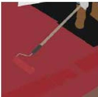
Aplique una capa inicial de Sikalastic®-602 BR sobre los soportes preparados y resistentes de la cubierta empleando el consumo adecuado.
