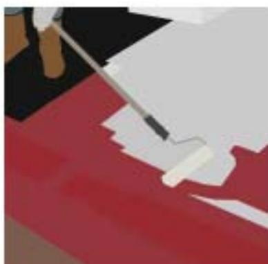
Aplique el Sikalastic®-621 TC ó Sikalastic®-622 TR/Sikalastic®-623 DR sobre el Sikalastic®-601 BC ó Sikalastic®-602 BR sobre todo el soporte de la cubierta incluyendo las zonas de detalles y de penetraciones. Aplique 1 ó 2 capas de Sikalastic®-621 TC ó Sikalastic®-622 TR/ Sikalastic®-623 DR dependiendo de los requerimientos del sistemas SikaRoof® MTC.
