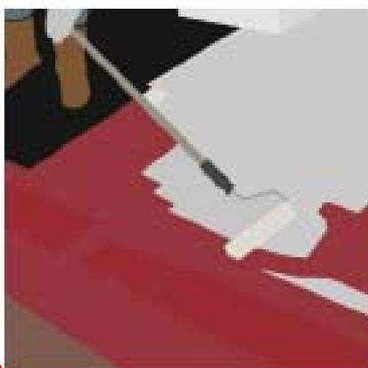
Aplique una capa de Sikalastic®-622 TR en las zonas protegidas o dos capas del Sikalastic®-623 DR en zonas expuestas directamente sobre el Sikalastic®-602 BR en todas las áreas de la cubierta incluyendo los detalles, los tubos y penetraciones.
