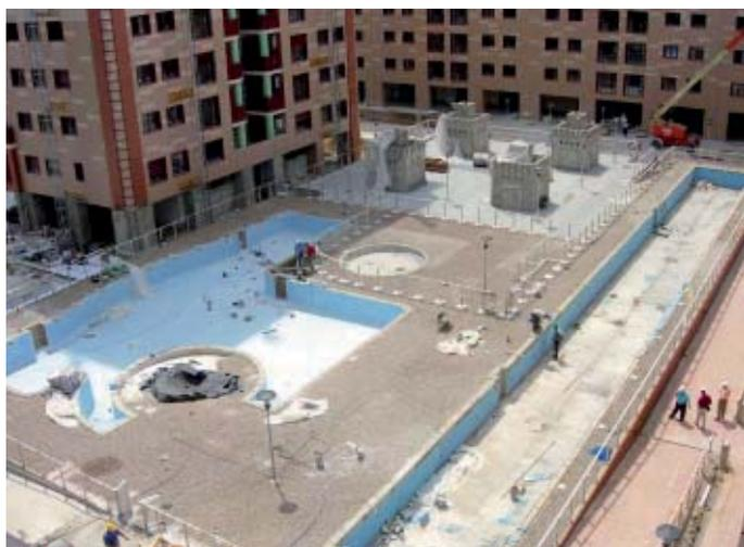
En las obras de construcción de Residencial Palmera, la empresa Imsortiz Cubiertas llevó a cabo la impermeabilización de las cubiertas invertidas transitables, los patios de los edificios y las piscinas del complejo.
