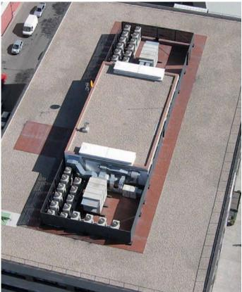
Aplicaciones Triángulo impermeabilizó los 1.771 m² de cubierta del edificio de la Sede Central de ABB, terminando con con grava las zonas comunesy dejando solada la zona de instalaciones.
