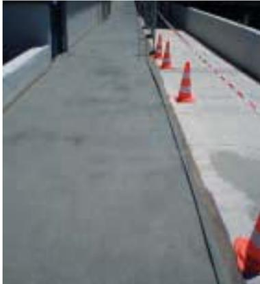
Como primer paso se procedió a la limpieza del hormigón existente mediante un fresado mecánico. Se dieron dos pasadas entrecruzadas y posteriormente se llevó a cabo un granallado mecánico y aspirado del polvo.
