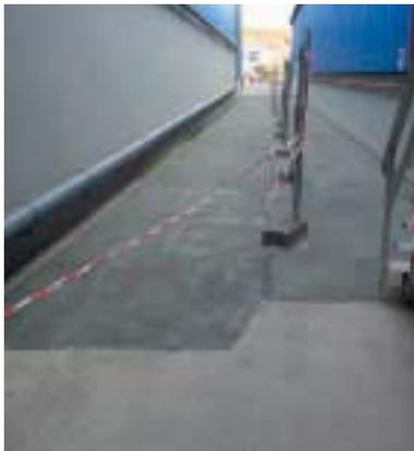
Finalmente se empleó el Sikafloor 357 SP —sellador de poliuretano con gran resistencia a la intemperie, excelente conservación del color y del brillo y buena resistencia al rayado— como capa final de sellado coloreada.
