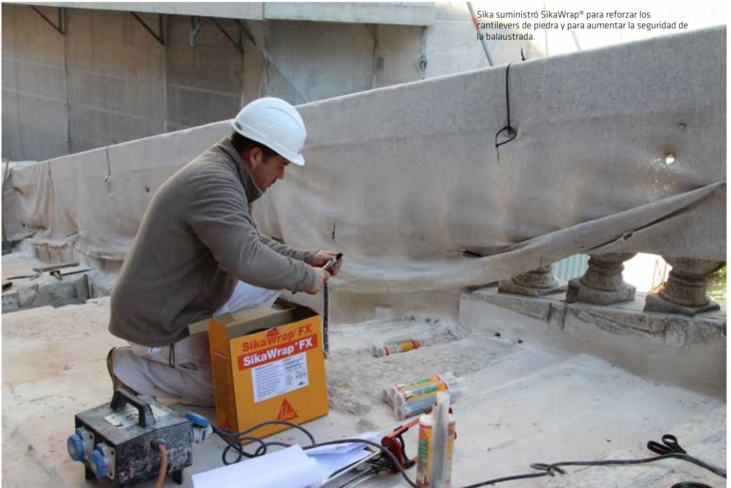
Toda la solución de fortalecimiento es ahora absolutamente no invasiva e invisible, ya que se oculta debajo de la cubierta.
