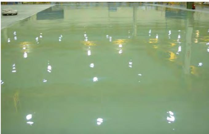
A Opteimsa se le encarga la ejecución de varios pavimentos autonivelantes a base de resina epoxi en las naves A-2, A-3 y A-5, en la factoría de Airbus en Illescas, Toledo. En este tipo de industrias son muy importantes las planimetrías, ya que los trabajos realizados, y las máquinas y softwares empleados requieren cotas y espesores determinados y perfectamente nivelados.
