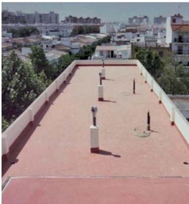
Se coloca después la lámina Sikaplan 12 G, de PVC plastificado, reforzada con una armadura de fibras sintéticas a base de poliéster, con un espesor de 1, 2 mm y en color rojo, por exigencias del cliente.
