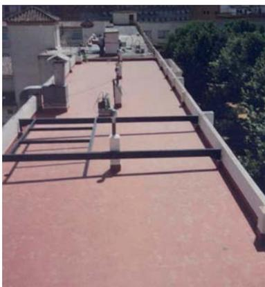
Una vez anclados y tensados todos los paños se procede a soldar la lámina entre sí termoplásticamente con aire caliente, con un solape igual o mayor a 5 cm.
