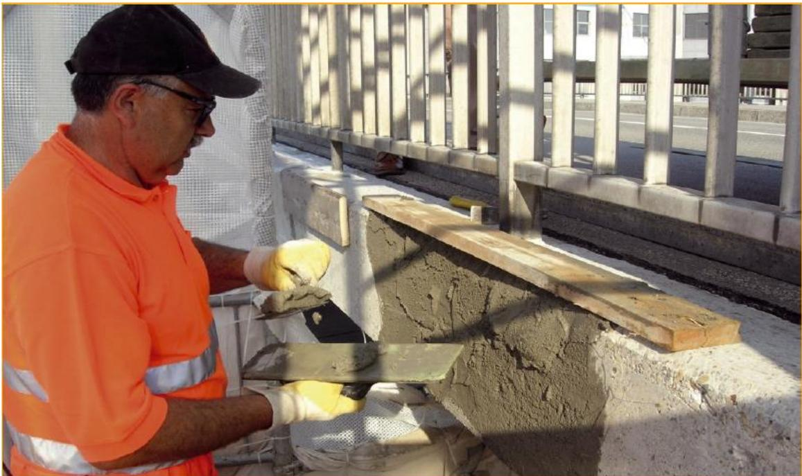
Y cuando realizamos una reparación por parcheo con morteros, ¿logramos el mismo efecto descrito en los tres puntos anteriores? Pues depende como la hagamos. Si hacemos una buena limpieza del acero, aplicamos concienzudamente una lechada pasivante y después ponemos encima el mortero, habremos logrado reproducir los tres mecanismos de adherencia descritos anteriormente:
