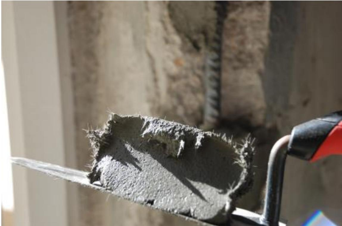
De las dos adherencias indicadas anteriormente querría analizar la que es quizá la más importante: la adherencia del mortero de reparación a la armadura del hormigón reparado. ¿Por qué es tan importante esa adherencia? Pues porque transmite los esfuerzos entre el hormigón y la armadura, de tal forma que actúen de una manera sinérgica.
