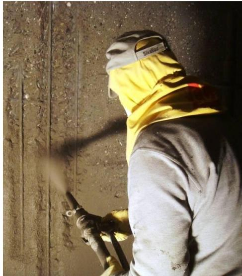
Por eso se aconseja la utilización de sistemas con la aplicación de una lechada pasivante sobre la armadura, que mejora el anclaje entre la misma y el mortero.
