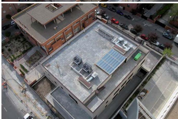
En esta obra nueva de impermeabilización de la cubierta del Centro del Alzheimer de Villaverde en Madrid, Aplicaciones Triángulo colocó un sistema de protección pesada con lámina de PVC Sikaplan® 12 SGMA, con aislamiento incluido y losa filtrante.
