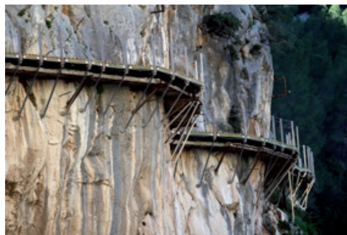
Vista general de la pasarela Rehabilitad (II)
