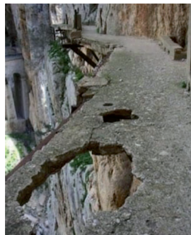
Estado de la pasarela antes de la rehabilitación (II)
