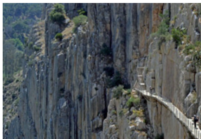
Vista general de la pasarela (II)
