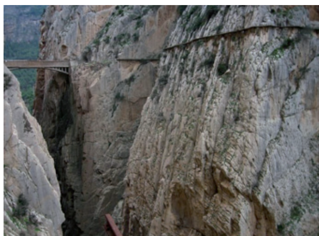
Vista general de la pasarela (I)
