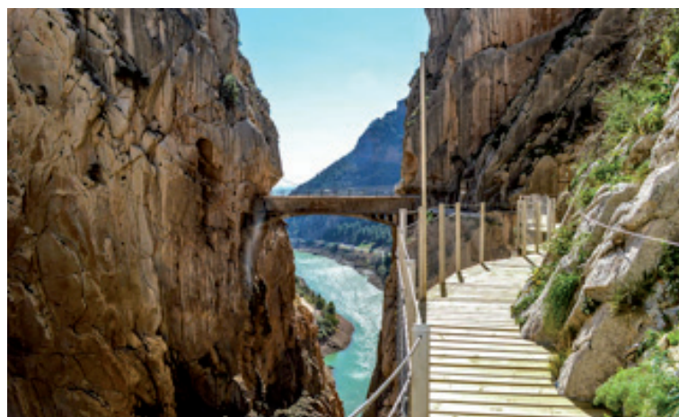
Vista general de la pasarela Rehabilitada (I)
