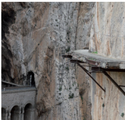
Estado de la pasarela antes de la rehabilitación (I)
