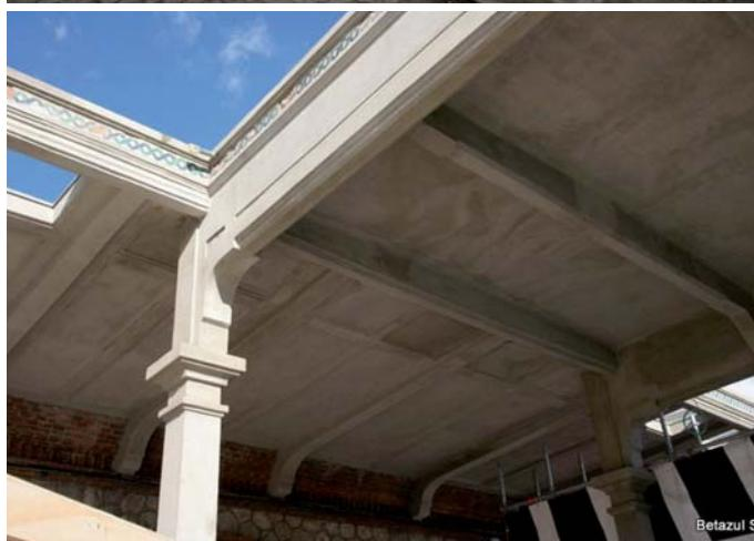
La estructura de la marquesina es una losa de hormigón armado, en voladizo, con nervios de mayor canto, que presentan cuelgue, tanto por la parte inferior como por la parte superior de la losa. En la estructura se pueden observar daños con pérdida de sección de hormigón, armaduras vistas y muy oxidadas, especialmente en las zonas de losa por la parte inferior.
