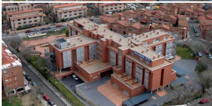
En este caso, Aplicaciones Triángulo se ocupa de una obra nueva e impermeabilización de la cubierta mediante un sistema de protección pesada con lámina 12 SGma con grava. Los petos se rematan con una solución estética en la que la lámina es revestida con Sikadur® 32 FIX con árido coloreado a saturación.
