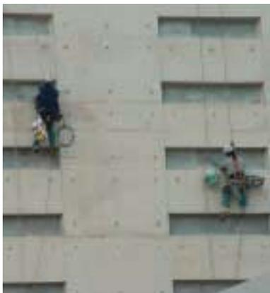
Los trabajos se realizaron utilizando técnicas de trabajos verticales y plataformas elevadoras de tipo tijera, con alturas de trabajo de 23 m.
