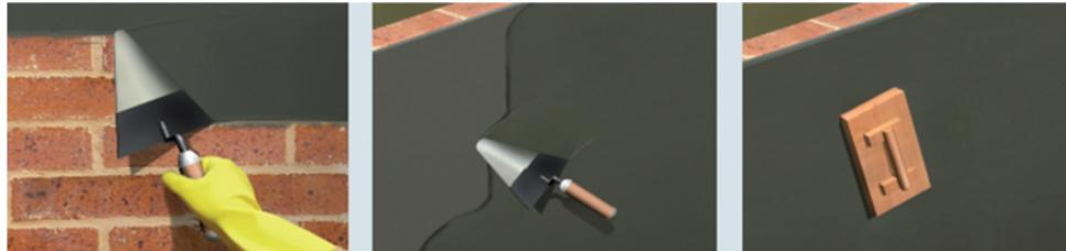
MONOCOMPONENTE, LISTO PARA SU USO CON LA SOLA ADICIÓN DE AGUA, A BASE DE CEMENTO, ÁRIDOS SELECCIONADOS Y AGENTES AIREANTES ESPECIALES. COMO CAPA DE ENFOSCADO.
