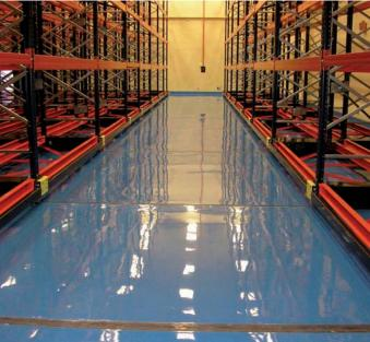
Para la realización de un pavimento continuo de resinas epoxi en el almacén automatizado del edificio 800 de Laboratorios Lilly, la empresa Opteimsa empleó un sistema de epoxi autonivelante con Sikafloor<sup>®</sup> 261.
