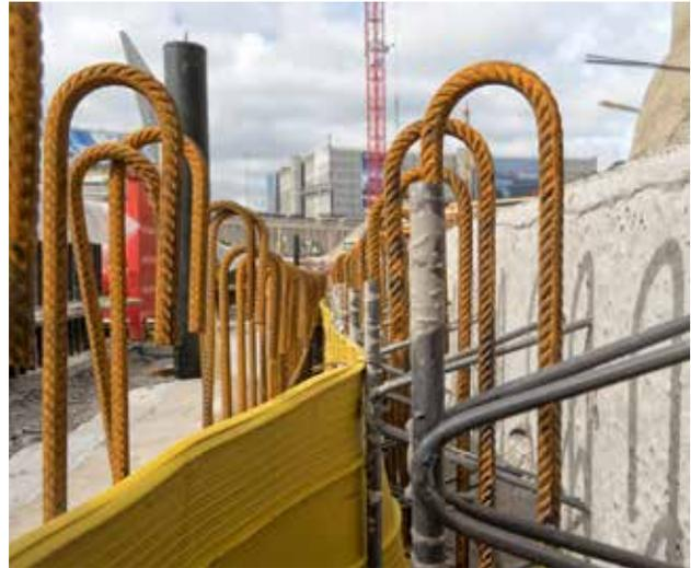
La impermeabilización incorporada a la estructura de hormigón hace que esta tecnología tenga un enfoque muy conveniente para contratistas, pero la durabilidad depende en gran medida de la calidad del agua subterránea, especialmente porque el agua salada conduce a la corrosión y reduce sustancialmente la durabilidad.
