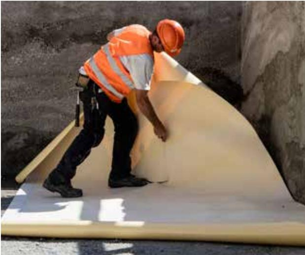
La última evolución de las láminas poliméricas es un sistema avanzado con completa adhesión a la estructura de hormigón. El material base cumple con las más altas pruebas de durabilidad, las cuales han sido utilizadas para membranas de impermeabilización de láminas poliméricas sueltas, sin embargo, la adherencia entre sí y los solapes no están normalizados ni investigados extensamente en cuanto a su durabilidad.
