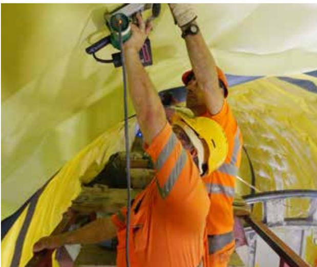
Durante casi medio siglo, las membranas poliméricas de PVC se han usado para la impermeabilización de túneles. La vida útil de las láminas se determina por las pruebas de materiales más exhaustivas y estandarizadas, incluyendo procedimientos de envejecimiento acelerado, por lo que proporcionan la máxima seguridad en cuanto a su durabilidad.
