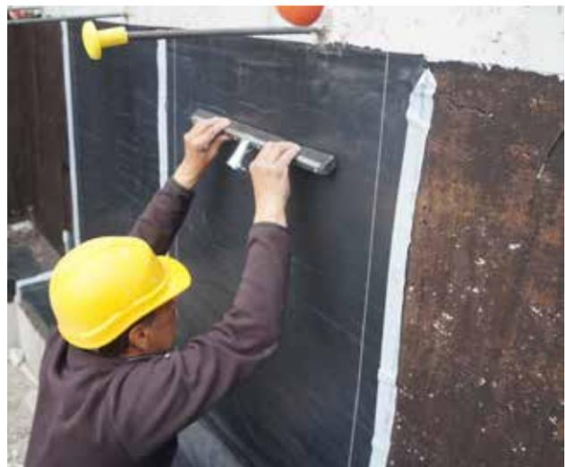
Las membranas bituminosas son una de las tecnologías de impermeabilización más antiguas, con una durabilidad limitada incluso en condiciones de agua subterránea no agresiva.
