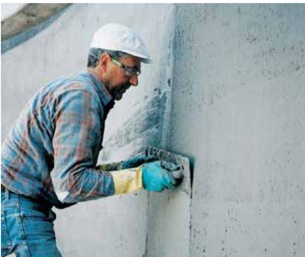
Los morteros aplicados manualmente o por proyección proporcionan una durabilidad razonable en agua dulce. Con el aumento del contenido de sulfato y magnesio, la durabilidad se ve reducida drásticamente.
