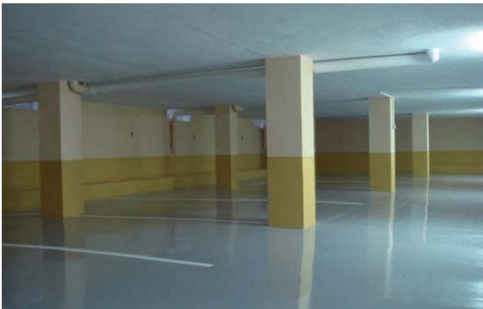
Reformas y Construcciones Iván Gándara solucionó las patologías en un garaje subterráneo en la Residencia Corel del Sur en Laredo (Cantabria). Se apreciaban importantes filtraciones de agua debido a una mala impermeabilización, un mortero de rodadura de baja calidad y la carencia de algún tipo de canalización. La rampa de vehículos, además, estaba demasiado inclinada, rozando por ellos los bajos de los coches en el suelo.
