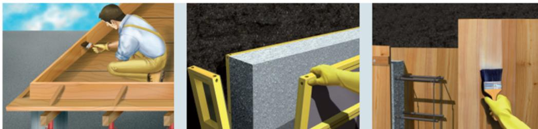
ES UN AGENTE DESENCOFRANTE QUE EVITA LA ADHERENCIA DEL HORMIGÓN O DEL MORTERO A LOS ENCOFRADOS.
