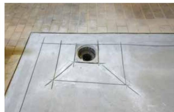
**SÁBADO POR LA MAÑANA:** Preparación del soporte después del curado del revestimiento.
