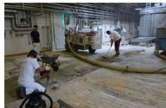
**VIERNES AL MEDIODÍA:** Retirada mediante medios mecánicos de la cerámica vieja y adhesivo epoxi. Preparación del soporte y limpieza.
