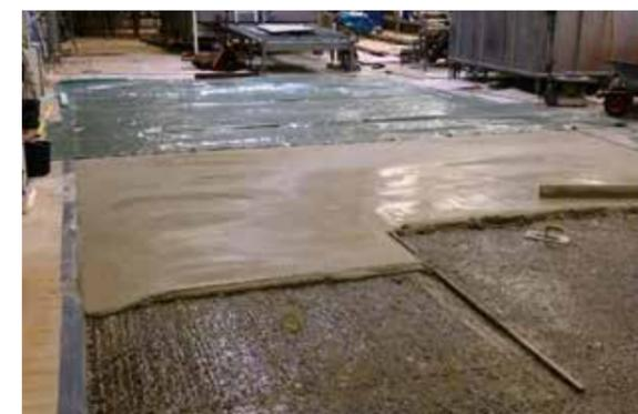
**VIERNES TARDE:** Aplicación del puente de unión y el revestimiento cementoso de curado rápido Sikafloor® HardTop-80.
