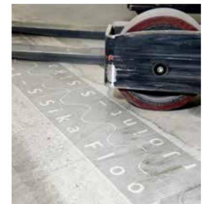
**Sika® FloorJoint S JUNTA CON MOVIMIENTO EN PAVIMENTO**
