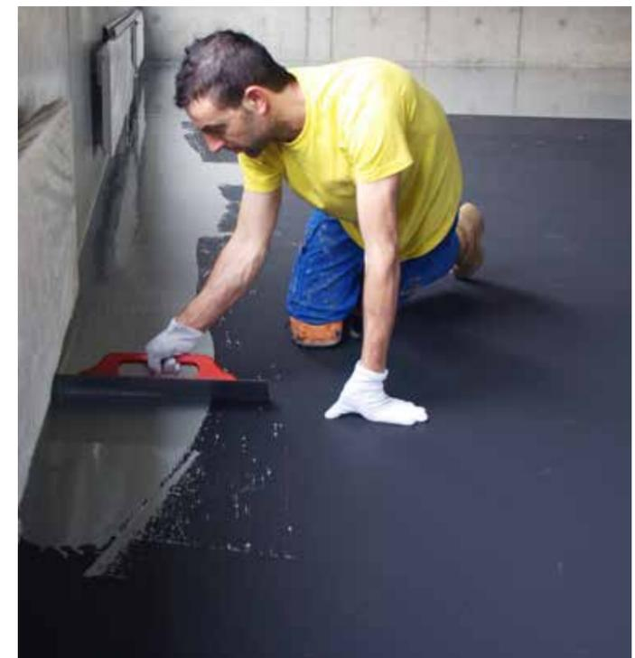
gón húmedo se seque - nuestras capas intermedias Sikafloor® EpoCem® se pueden instalar directamente en hormigón verde/nuevo y húmedo.
