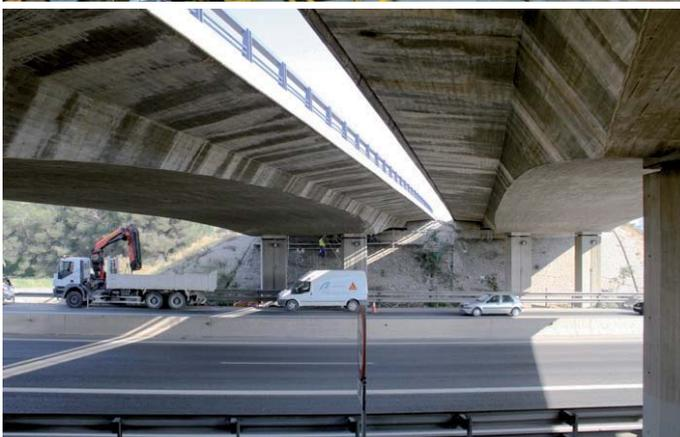
Para la reparación de un puente en la autovía A-7 a su pasó por El Palmar, Betazul hubo de ejecutar, fundamentalmente, trabajos de formación de apoyo con Sikadur 42 HES y relleno de la zona de cabeza de las barras con Sika Grout.
