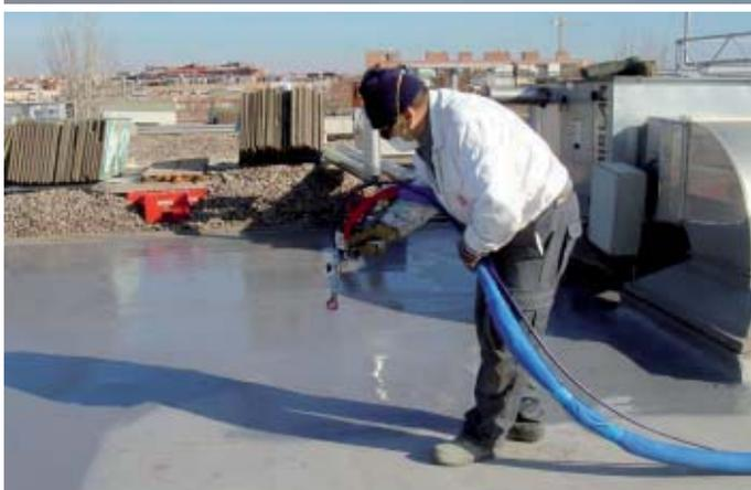
Pintura Industrial Reus realizó tres tratamientos en la obra de la impermeabilización de la cubierta de la nave de envasado de la empresa fabricante de cervezas Damm: la reparación de entregas y solapes en salidas, coronación contorno nave y la impermeabilización cubierta.
