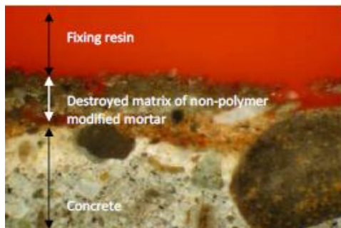
Revestimiento a base de producto cementoso
