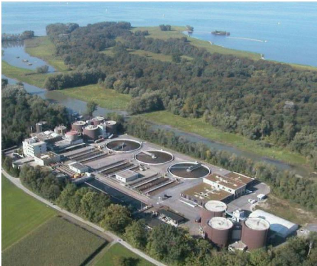
Vista aérea de la planta E.D.A.R. Altenrhein en Sant Gallen (Suiza)
