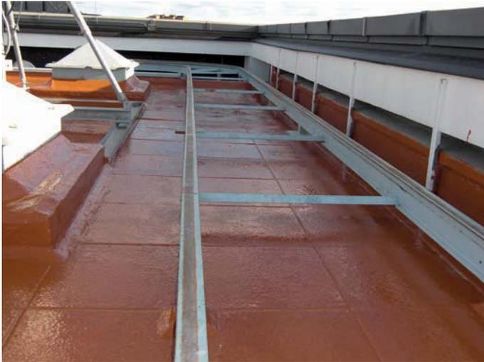
La empresa Constriberic llevó a cabo la impermeabilización de la cubierta de la sede central de ACS en la Avenida Pío XII de Madrid mediante el sistema de membrana impermeabilizante in situ SikaLastic
