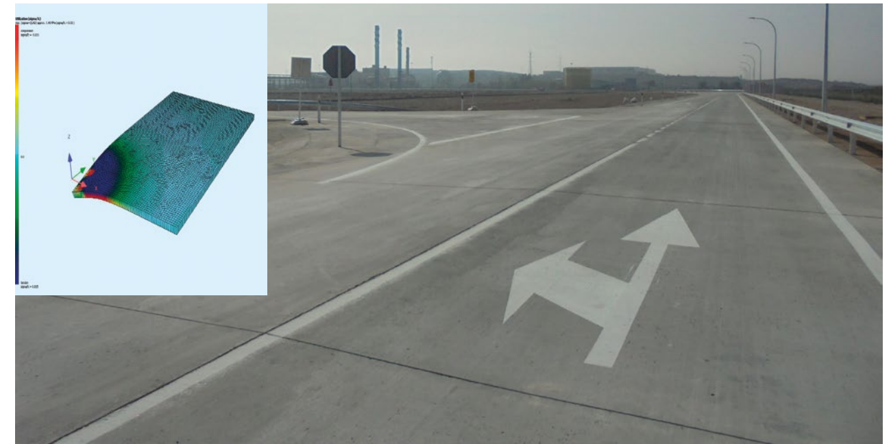
Solera estructural modelizada con 5 kg/m³ de Sikafiber para cargas superiores a 15 t/m²
