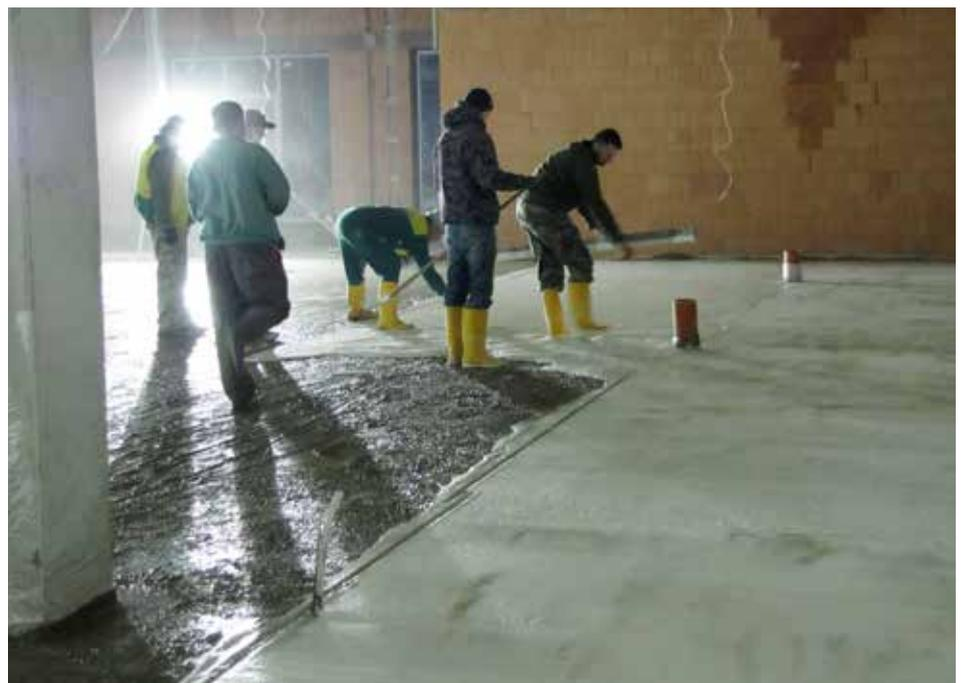
Aplicación Sikafloor®-3 + CorCrete en el almacén de materiales de construcción Dek Znojmo en la república checa. Rehabilitación de losa de hormigón de 1200 m<sup>2</sup> con el color gris claro.
