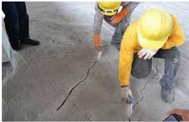
Reparación de una grieta sin movimiento. Una vez abierta la grieta es rellenada e inyectada usando resinas epoxi Sikadur®-52 o Sikafloor®-156 .
