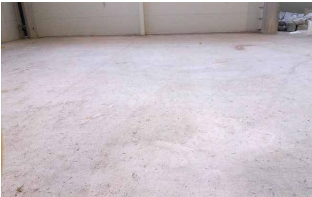
Pavimento deslaminado, acabado con endurecedor en polvo, después de la preparación del soporte
