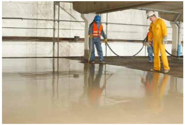
Aplicación de una capa de Sikafloor®-30 Level en un parking
