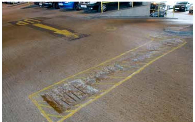
Los productos químicos agresivos degradan el hormigón. La imagen muestra el ataque por cloro de sales de deshielo.
