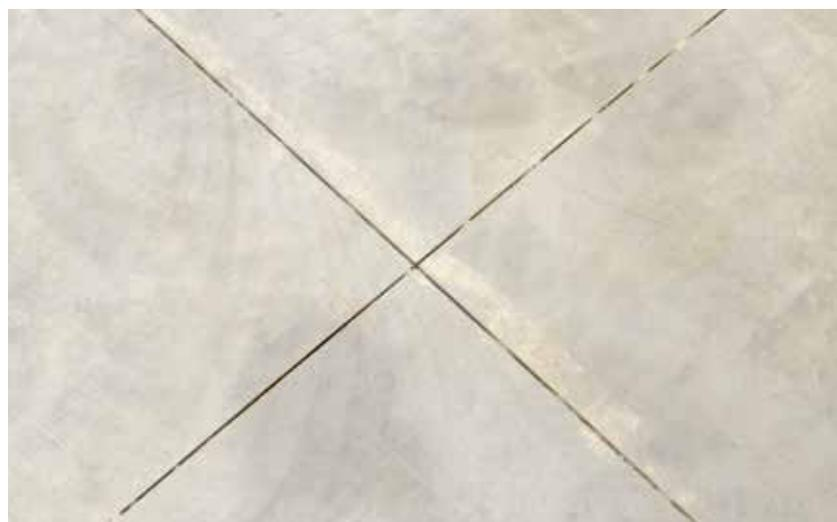
Las juntas de retracción serrada permiten la retracción inicial de la losa de hormigón.
