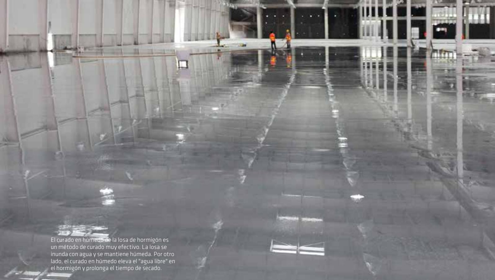
El curado en húmedo de la losa de hormigón es un método de curado muy efectivo. La losa se inunda con agua y se mantiene húmeda. Por otro lado, el curado en húmedo eleva el "agua libre" en el hormigón y prolonga el tiempo de secado.
