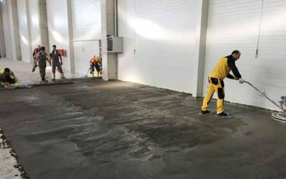
El sistema de solera de reparación SikaScreed® HardTop permite una aplicación rápida. Mientras los operarios del fondo están extendiendo todavía la solera, la operación de fratasado (delante) puede comenzar en 90 minutos
