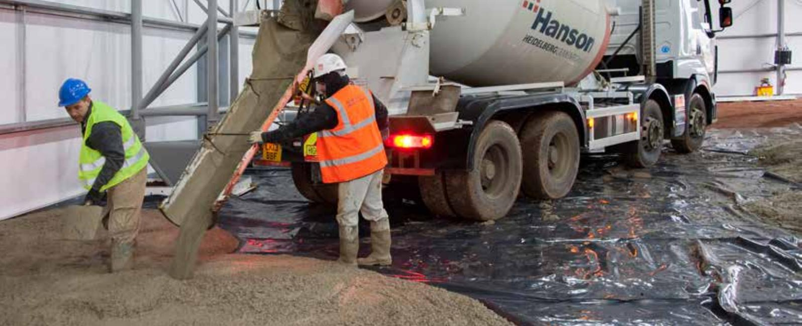
super-plastificantes se utilizan normalmente en diseños de mezcla de hormigón para losas de pavimentos de hormigón para ajustar la consistencia. Estos aditivos mejoran la resistencia del hormigón porque reducen la cantidad de agua requerida para mantener una buena trabajabilidad. Esto minimiza la relación de agua a cemento y disminuye la permeabilidad del hormigón.
