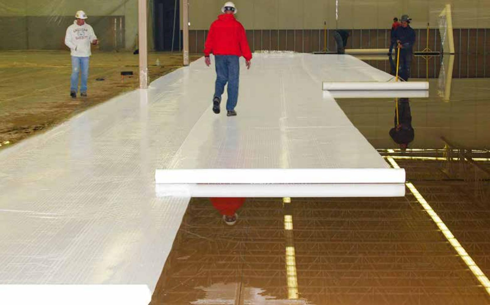
Una solución de curado definitiva: el sistema de manta de retención de agua Sika® Ultracure combina métodos de curado en húmedo y en lámina.
