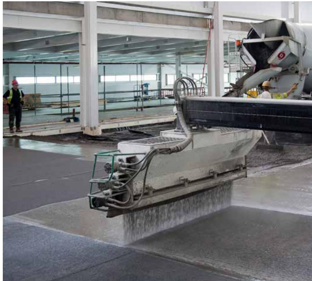
Espolvoreado mecánico del endurecedor en polvo Sikafloor®-2 SynTop sobre hormigón fresco.
