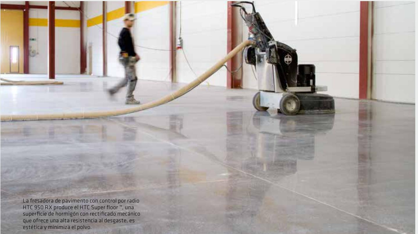
La fresadora de pavimento con control por radio HTC 950 RX produce el HTC Super floor™, una superficie de hormigón con rectificado mecánico que ofrece una alta resistencia al desgaste, es estética y minimiza el polvo.
