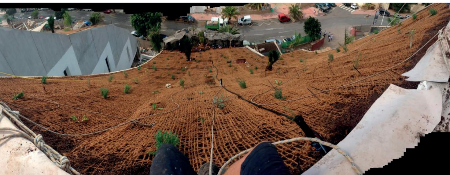
Instalación de los elementos que componen la cubierta ajardinada inclinada
