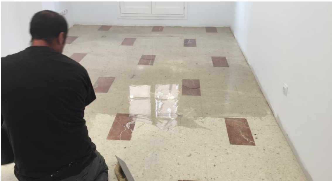
Un detalle de la aplicación de la capa de imprimación SikaFloor 161 a llana metálica. A su vez se aprecia la preparación del soporte en cuanto a limpieza y apertura del poro del terrazo existente en el pavimento.
