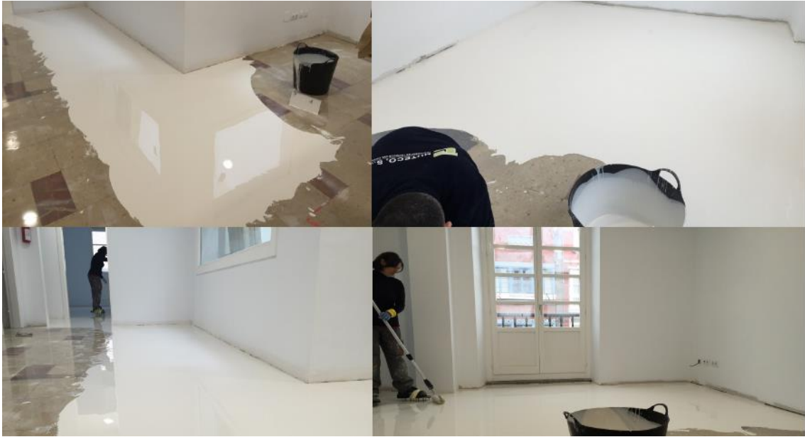
Fase de la aplicación de la capa principal, extendida a llana dentada
