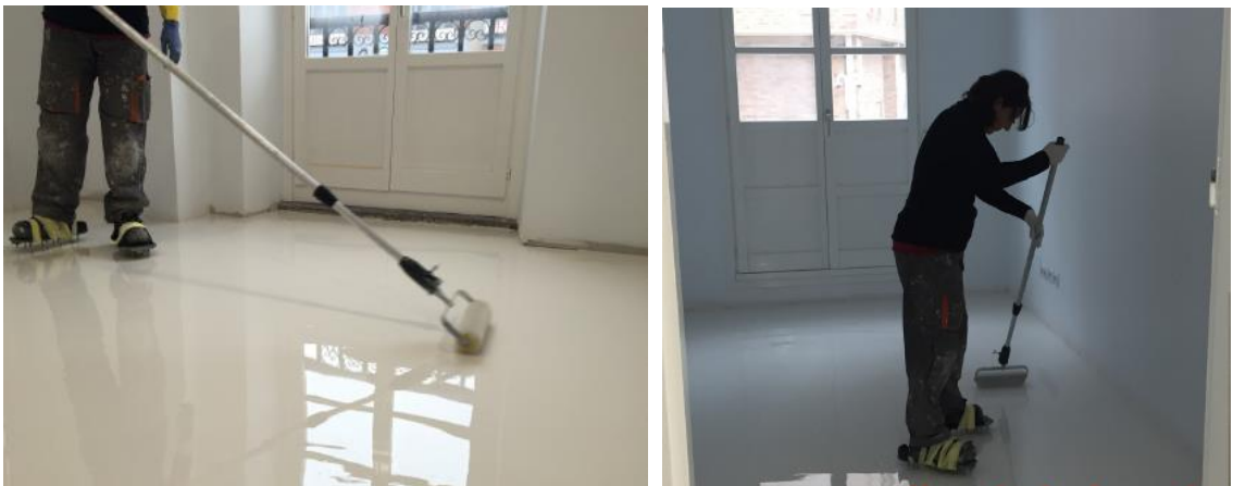
Detalles de la fase de eliminación el aire ocluido, pasando el rodillo de púas a todo el pavimento antes de que empiece a catalizar la resina SIKAFLOOR 264
