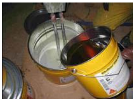
Mezclado de Sikafloor-264
