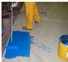
Sikafloor-264 aplicado como revestimiento
