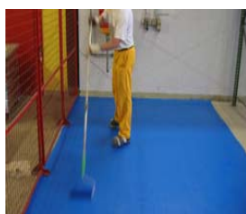
Sikafloor-264 extendido a rodillo.
