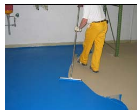
Sikafloor-264 aplicado como capa de sellado con llana de goma.
