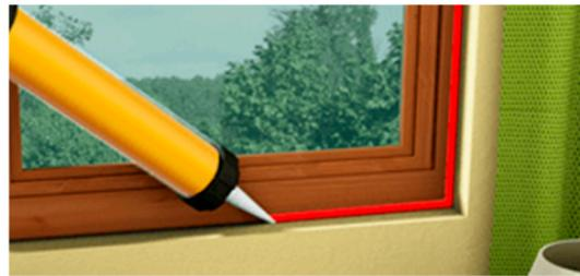
SELLADOR INTUMESCENTE EN BASE AGUA PARA EL SELLADO DE JUNTAS DE CONEXIÓN ASÍ COMO DE TUBOS DE CABLES Y DE PENETRACIONES EN SOPORTES POROSOS Y NO POROSOS.
