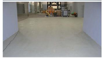
Para la realización de un pavimento en el Palacio de Congresos de Maspalomas, Aplicaciones Químicas Insulares empleó un sistema de epoxi autonivelante con Sikafloor 261.
