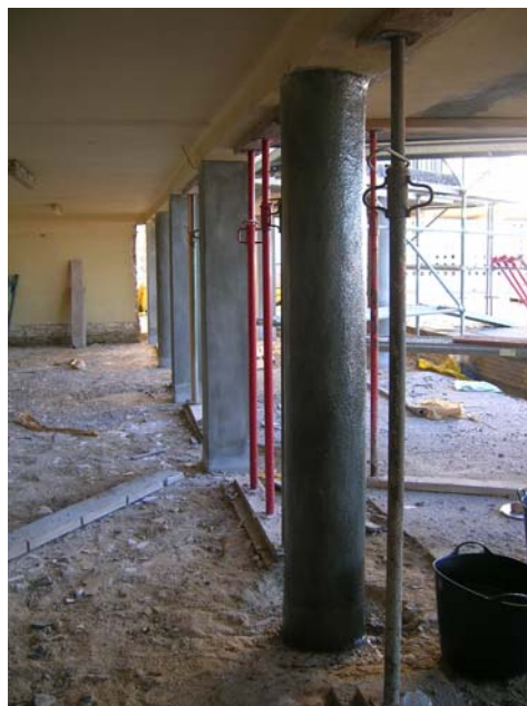
Imprimación del soporte mediante brocha
